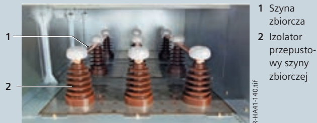
Przedział szyn zbiorczych obejmujący 3 pola (przykład 24 kV) Widok z boku
